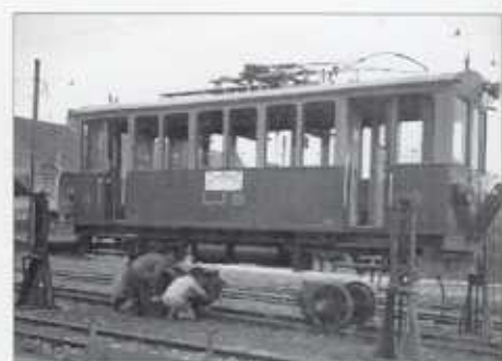
Ce 2/2 11 bei Revisionsarbeiten im Depot Langenthal (Foto: Archiv OSST)
