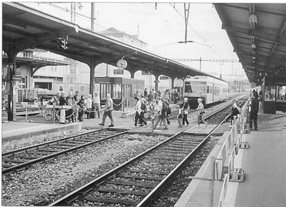
Bis die Unterführung fertig ist, «lebt» der Ketteliübergang weiter. Er wurde um ca. 50m verschoben.
