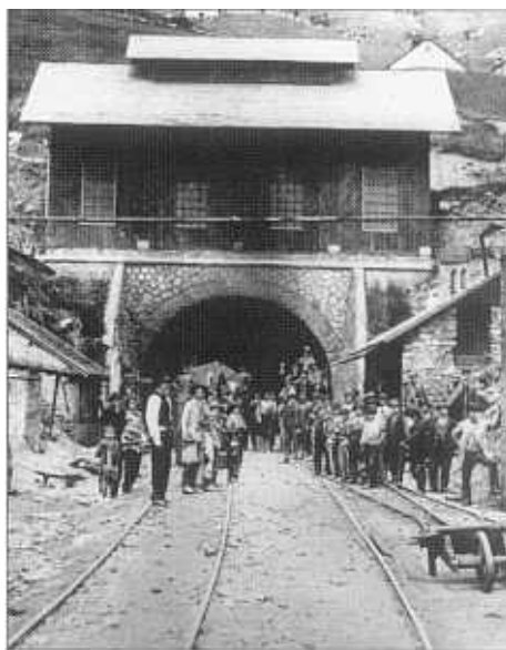
Die Bauarbeiter versammeln sich vor dem Südportal des Gotthards in Airolo für den Fotografen (Foto: Archiv VHS)
