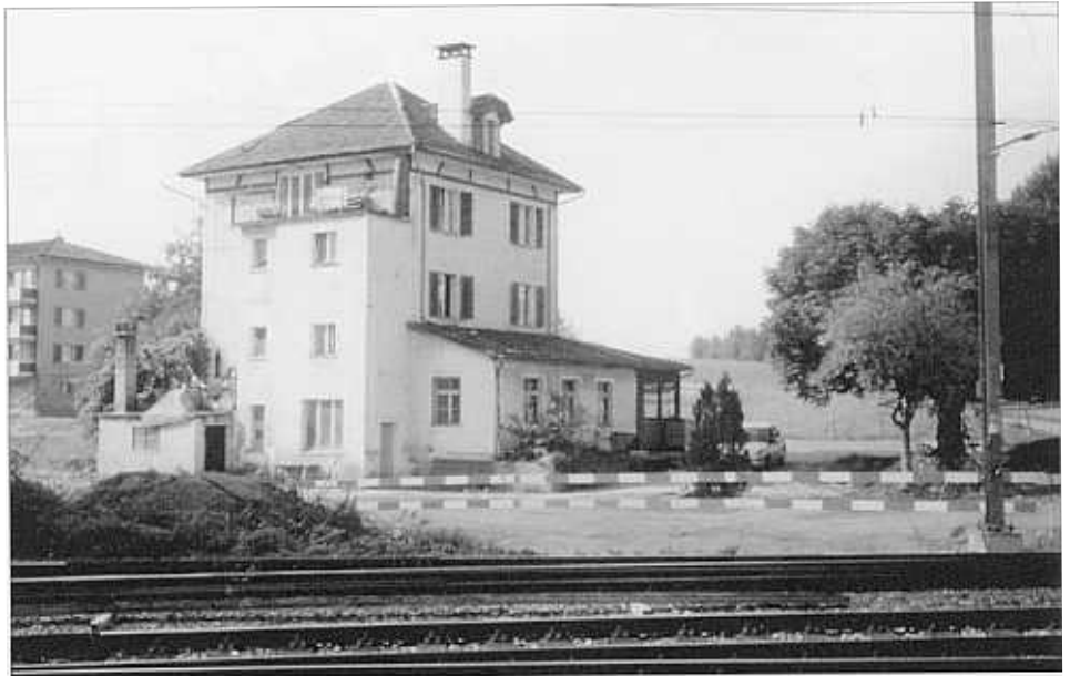
Das Vorbildhaus wurde in der Zwischenzeit bereits abgebrochen
