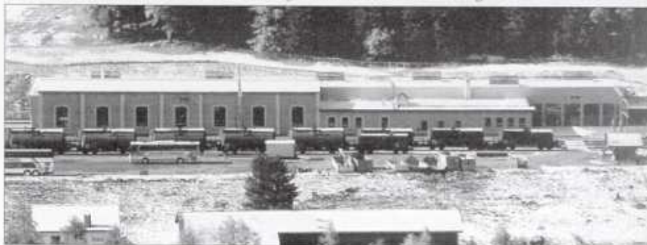
Foto des RhB-Depots in Pontresina: Grundlage für die Dreisatz-Berechnung
