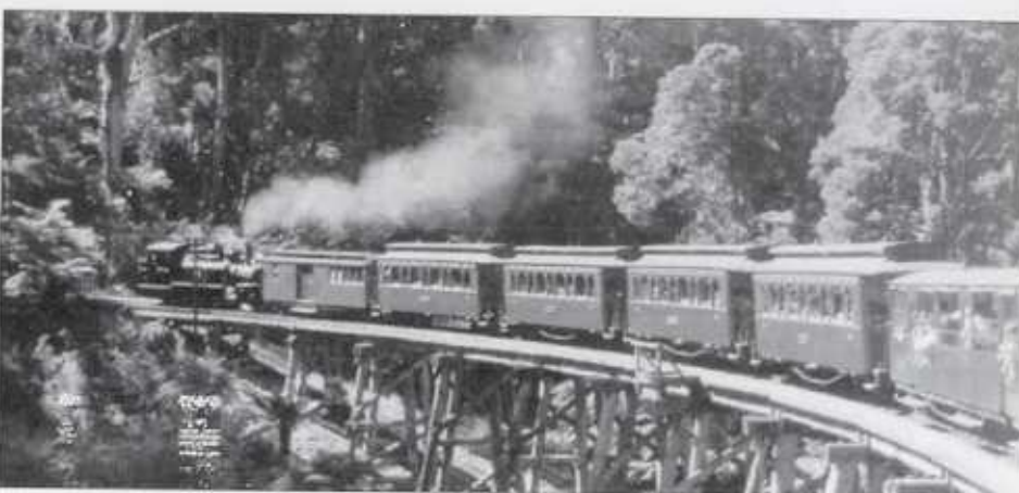
Puffing Billy Dampfzug auf der 85,3m langen und 12,8m hohen Trestle Bridge (alle Fotos: 20.3.98, M. Klausner).
