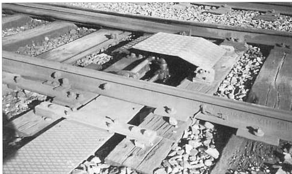
Gelenkspitzenverschluss, Bauart Jüdel, mit elektromotorischer Antrieb, aufgenommen in Kirchberg-Alchenflüh (Foto: H. Berneth).
