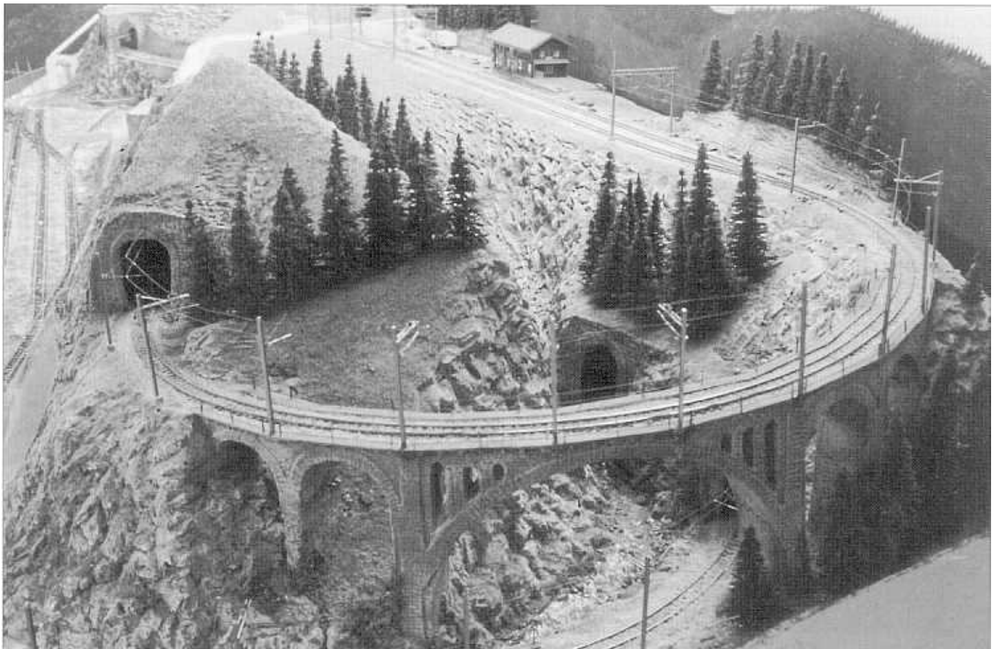
Einfahrt über eine formschöne Steinbogenbrücke in den Bahnhof Wiesen (Foto: C. Kliwer).
