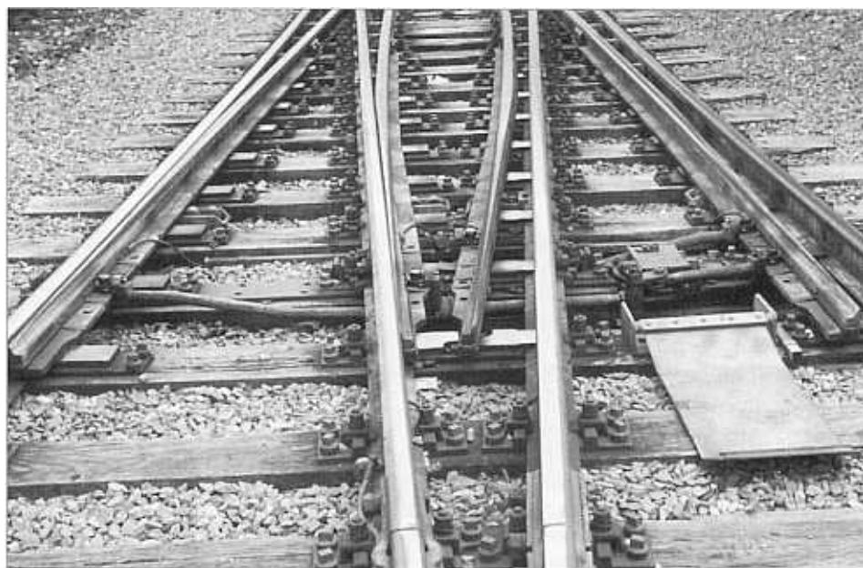
DKW mit Gelenkspitzenverschluss Bauart Jüdel, gut sichtbar die Anordnung der Stempel und Koppelstangen (Foto: H. Berneth).
