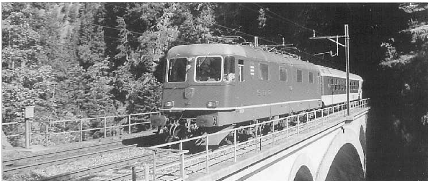
Die realisierten Alpenbahnen sind geprägt von Kunstbauten wie Brücken und Tunnels. Hier eine Prototyp-Re 6/6 602 bei Wassen (30.7.98; Foto: M. Klausner)
