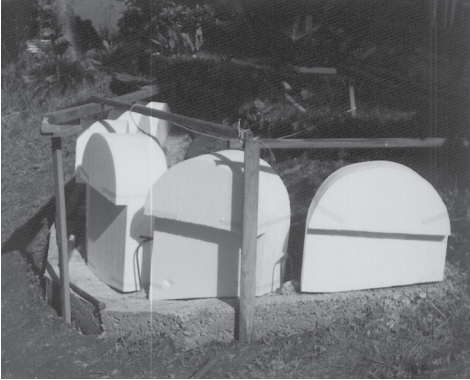
Bild 2: Die zugeschnittenen Styroporplatten müssen möglichst genau ausgerichtet werden.
