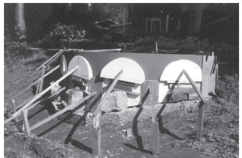
Bild 3: Die fertige Schalung, gut sichtbar das biegbare Pavatex
