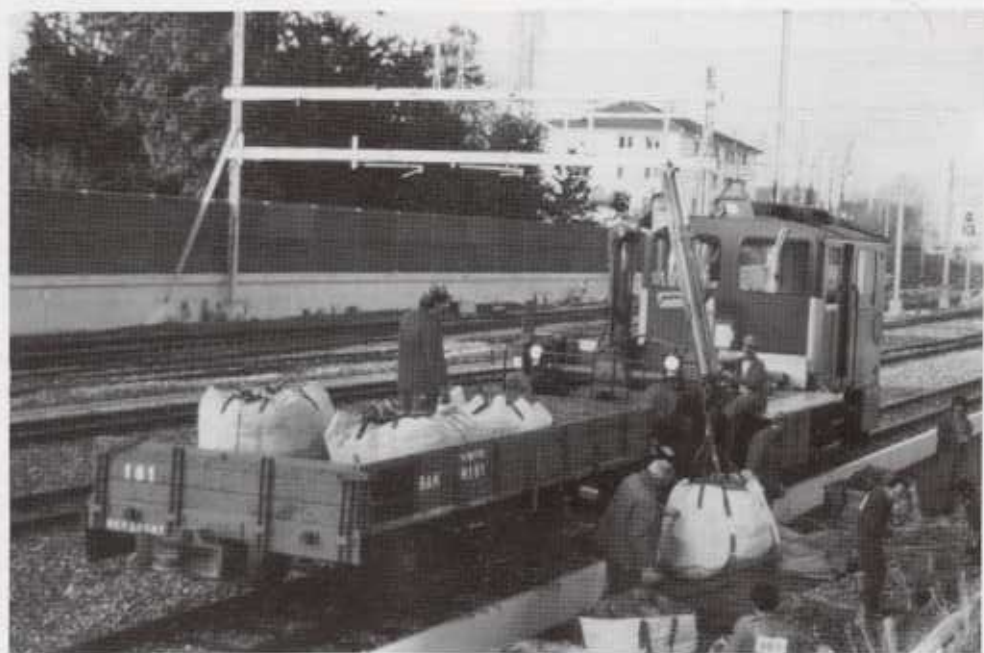
Ein Bauzug, bestehend aus dem Tm 2/2 41 und dem M 181, beim Abtransport von Aushubmaterial (4.4.95, Morges, Foto M. Klausner)
