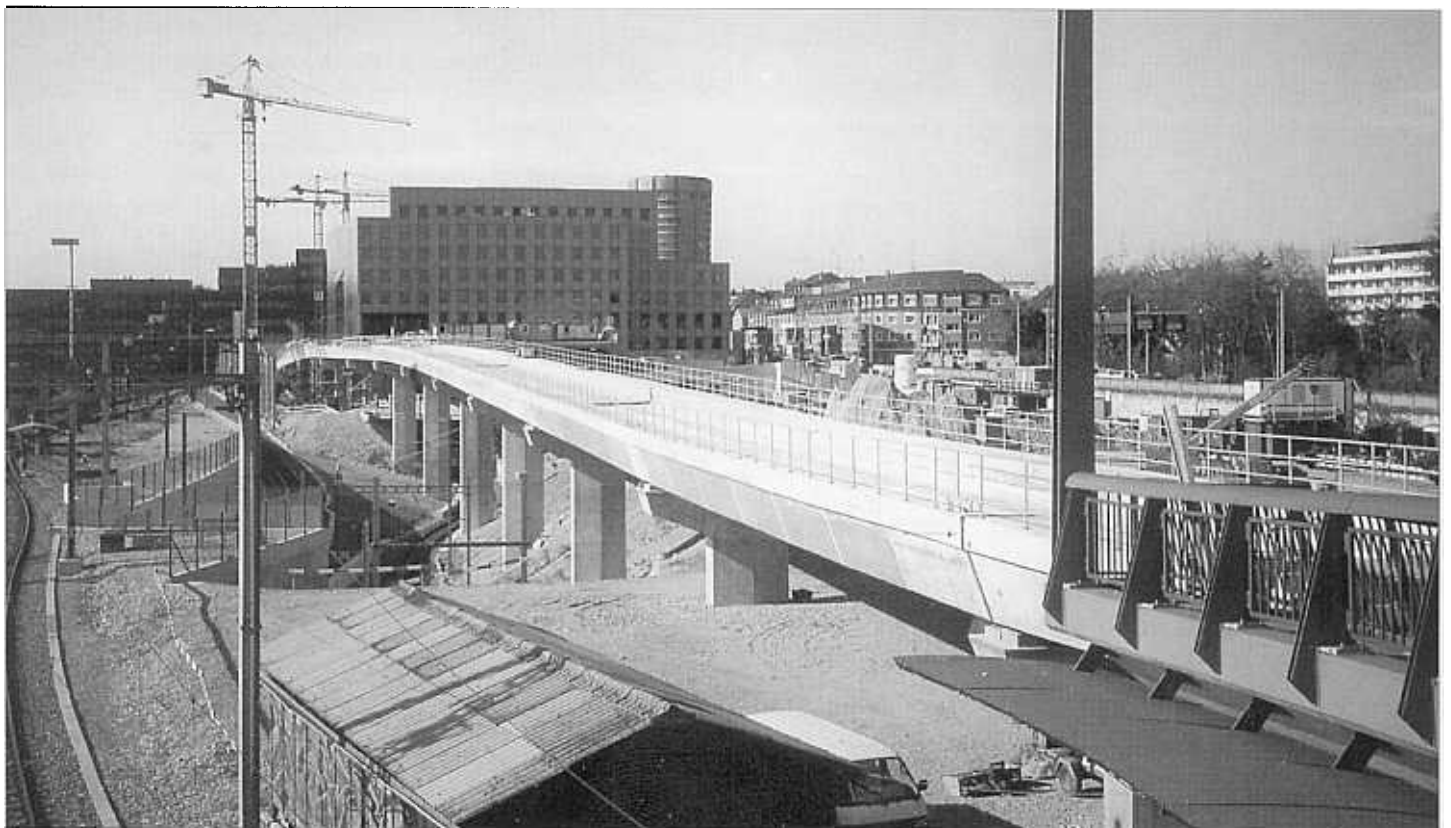
Im Rohbau fertiggestellter Viadukt über den tiefer gelegten Postbahnhof (6.3.00; Foto: A. Hügli)
