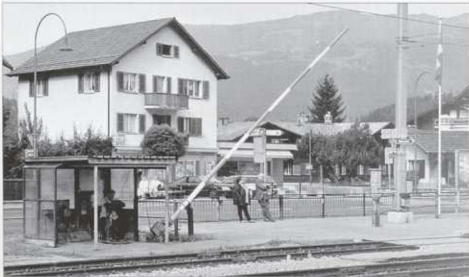
Barrierenposten Wilderswil. Da der Bahnübergang nur noch von Radfahrern und Fussgängern benützt wird, werden die Schlagbäume nur noch halb geöffnet.
