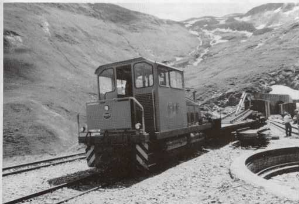
Bauzug mit HGm 2/2 in der Station Furka (Foto M. Klausner)
