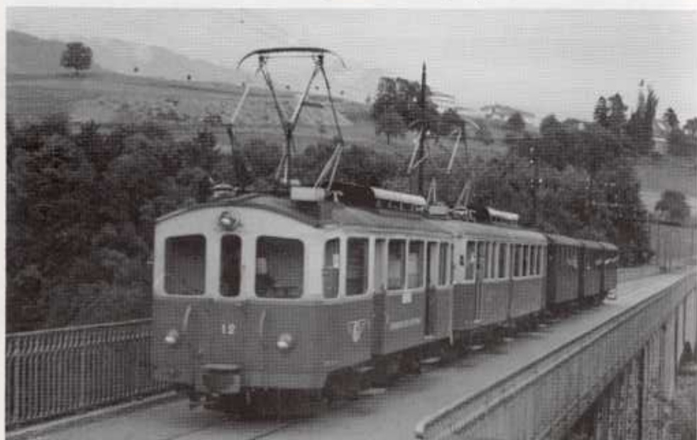
Doppeltraktion mit BCFe 2/3 12 und einem BCFe 4/4 auf dem Fenil-Viadukt. Dieser wird seit der Einstellung der Linie St. Légier-Châtel St. Denis als reine Strassenbrücke verwendet (Foto Archiv CEV).
