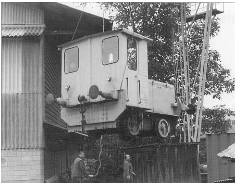
Ablad der O&K-Diesellok auf den provisorischen Standplatz (20.10.03; Foto: R. Wymann)
