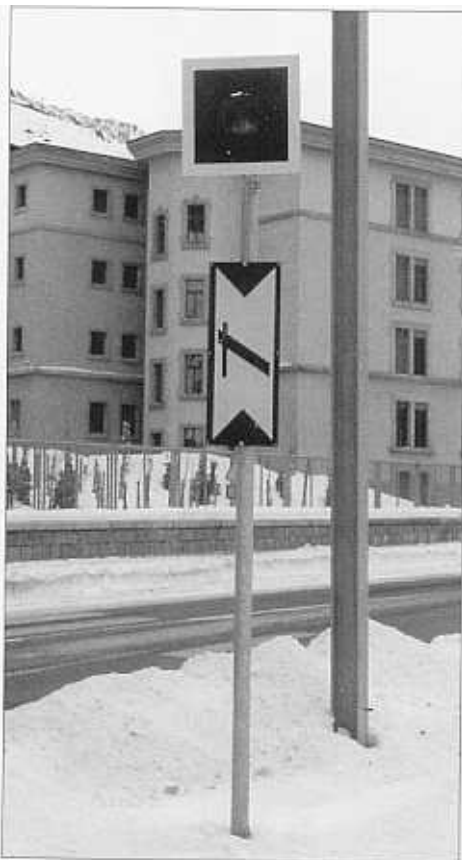
Blinklicht für den Bahnübergang mit Merkzeichen für einen Geleisemagneten (Andermatt aus Richtung Göschenen, Dezember 1998)
